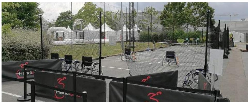
**Structure filet pare-balle (filets de 30 m de long x 20 m de large x 2,50 m de haut; 24 poteaux de 2,50 m de haut sur embase de 0,30 m x 0,30m, 30 lests de 30kg) pour délimiter la zone de pratique de tennis fauteuil et empêcher les balles de sortir de cette zone**
